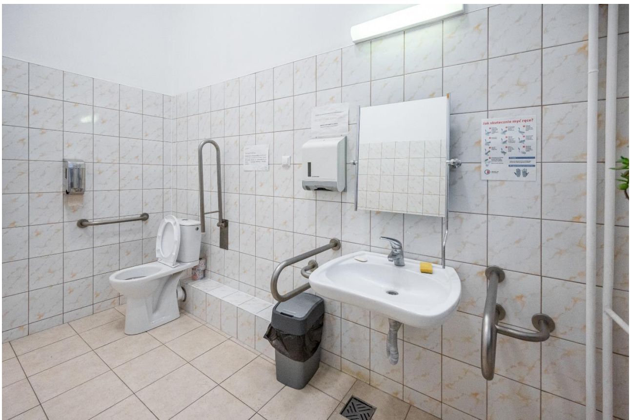
Zdjęcie 18 Widok na toaletę dostępną znajdującą się na II piętrze.
