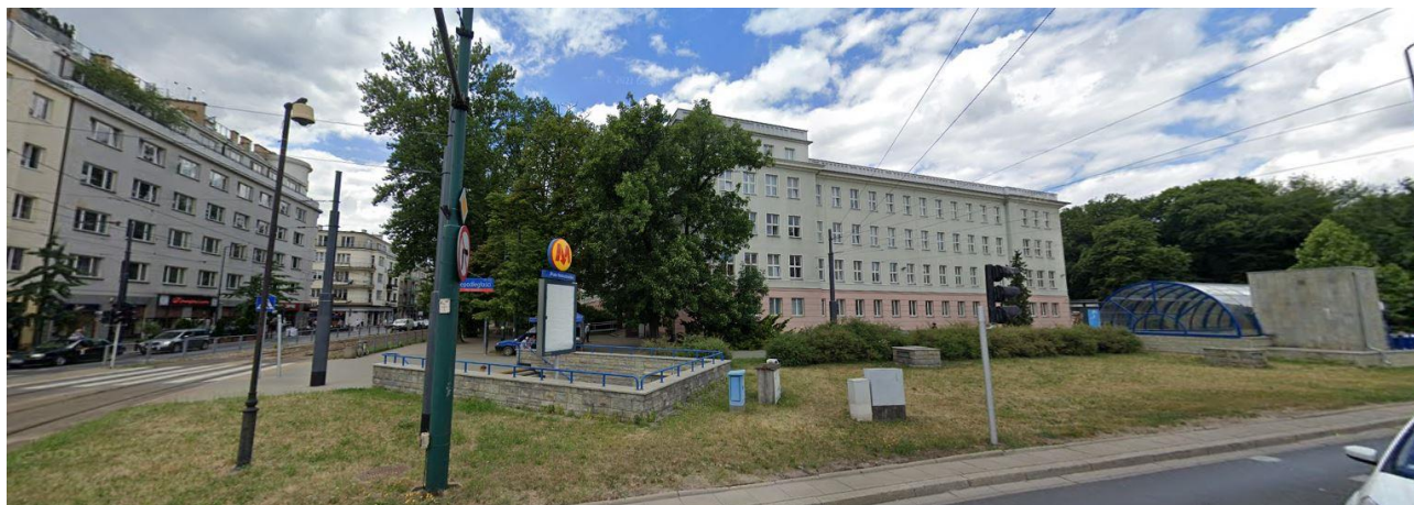
Zdjęcie 4 Widok wejścia na stację metra Pole Mokotowskie.
