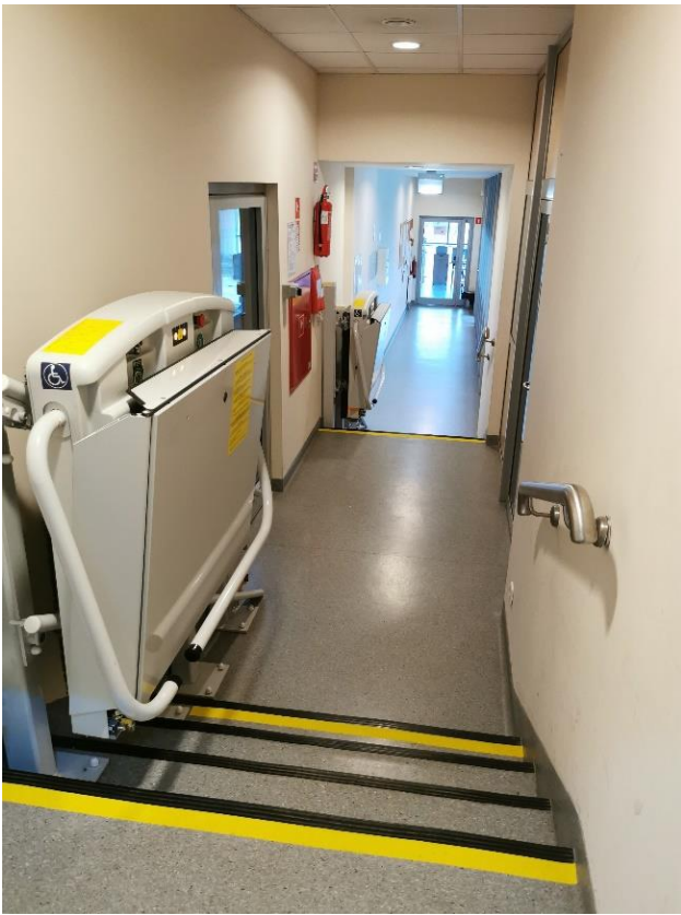
Zdjęcie 16 Podnośnik przyschodowy – platforma transportowa do masy 225 kg.
